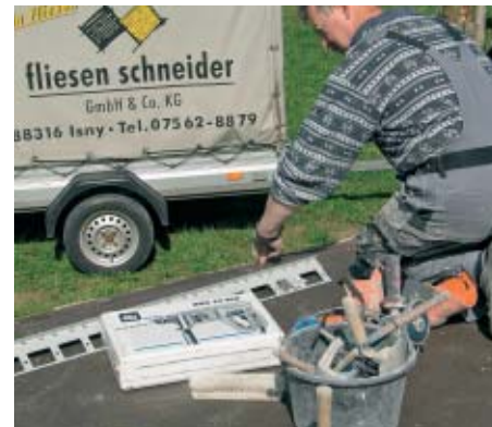
9. ... wurde jetzt zunächst ein Drainabschlussprofil an den Kanten der Platte angeordnet und mit Dübeln und Edelstahlschrauben befestigt.
