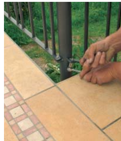
32. Jetzt konnten die Geländerelemente mit den Halterungen an den Pfosten verbunden werden.
