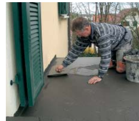
6. Nach Trocknung wurde die gesamte Fläche mit einer Dichtschlämme versiegelt, ebenso der Sockelbereich des Hauses.
