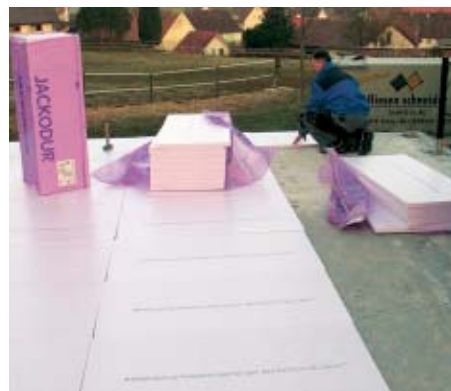
1. Zuerst wurde eine dicke Lage aus geschlossenzelligen, druckfesten Schaum-Polystyrol-Platten als Wärmedämmung ausgelegt.
