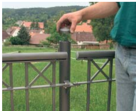
36. Abschließend wurden noch auf alle Rohrpfosten passende Metall-Abdeckkappen gesteckt und mit einem Schraubchen gesichert.
