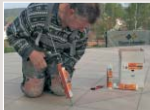
19. Die Dehnungsfugen am Wandsockel und bei der Austrittsstufe wurde mit Silikon ausgefügt, ...
