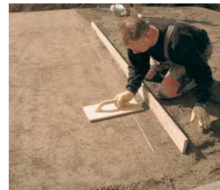
5. Mit Hilfe von Messgeräten, Abziehbrettern und Reibebrettern wurde das bislang fehlende Gefälle vom Haus weg angelegt.
