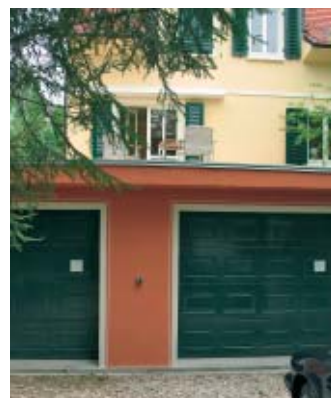
23. Vorn steht das Flachdach der Doppelgarage ein gutes Stück über. Die Geländerpfosten ...
