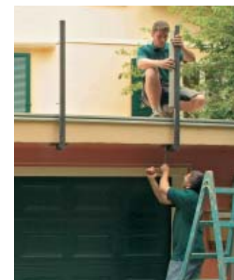
26. Die ausgerichteten Pfosten wurden dann mit einem Drehmomentschlüssel angeschraubt.
