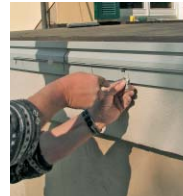
11. Außen am Abschlussprofil wurden die Dachrinnenhalter dem gewünschten Gefälle entsprechend angebracht.
