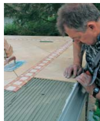
15. Danach folgte noch eine Reihe der großformatigen Keramik, parallel zum Randprofil verlegt.
