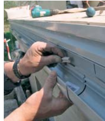
17. Rundum wurden die Dachrinnen und die Rinnenverbinder an den Profilen angebracht und ...
