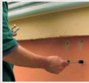
28. Wegen der Ziegel-Hochlochsteine kamen hier Anker mit Siebhülse zum Einsatz.
