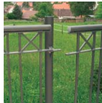
32. Jetzt konnten die Geländerelemente mit den Halterungen an den Pfosten verbunden werden.
