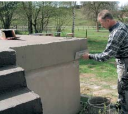
7. Die höher gewordenen Stirnseiten des Flachdachs wurden mit Mörtel sorgfältig glattmodelliert.
