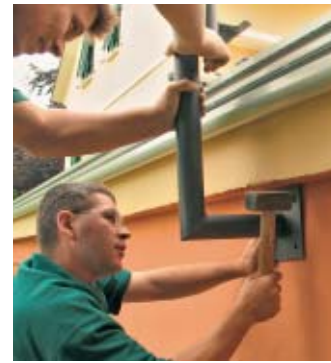
30. ... drehend eingeführt und gefühlvoll mit dem Fäustel waagrecht ausgerichtet. Nach der ...
