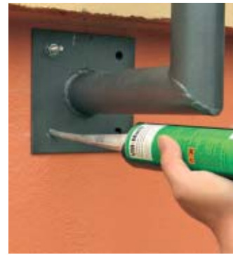
29. Vom Ende der Siebhülse her wurde Verbundmörtel eingefüllt (hier von Reca Norm), die Anker ...
