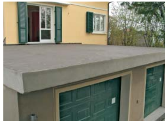
8. Die neue Platte der Hochterrasse war jetzt verlagereif. Aufgrund ihrer Größe fällt viel Oberflächenwasser an. Dieses sollte mit System abgeleitet werden. Deshalb ...
