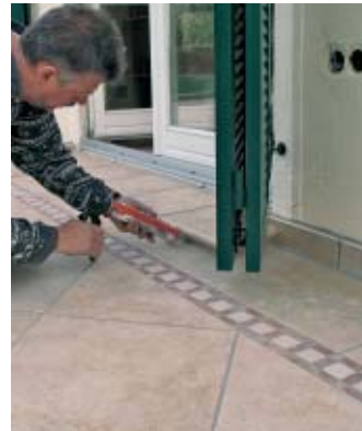
19. Die Dehnungsfugen am Wandsockel und bei der Austrittsstufe wurde mit Silikon ausgefügt, ...
