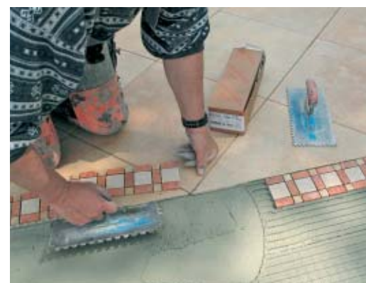
14. ... eingelegt. Im Abstand von 45 Zentimeter plus zwei Fugenbreiten hat man als schmückendes Element umlaufend eine Natursteinbordüre verlegt.
