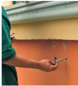
28. Wegen der Ziegel-Hochlochsteine kamen hier Anker mit Siebhülse zum Einsatz.
