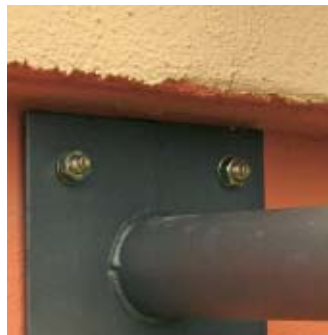
31. ... Aushärtezeit des Mörtels wurden die Montageplatten mit Muttern angeschraubt.
