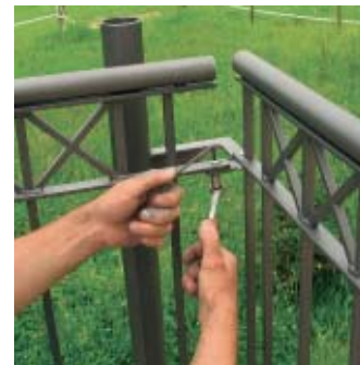
33. Die Eckbereiche wurden dabei mit Hilfe einer Doppelverbindung ganz besonders stabilisiert.
