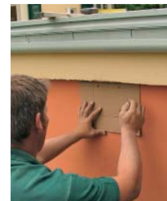
27. Seitlich hat man die Befestigungspunkte für das Geländer an den Garagenwänden markiert.
