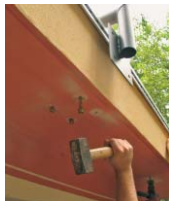
25. Dann wurden jeweils vier Spreizanker mit dem Fäustel in die Betondecke getrieben.
