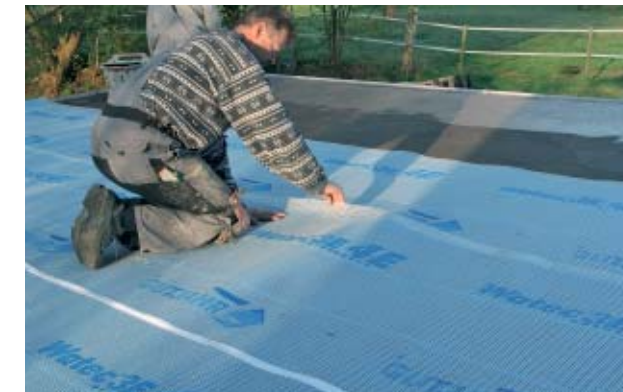
12. Die Drainagematte muss mit dem Gittergewebe nach oben und mit den Drainkanälen in Richtung Gefälle ausgelegt werden. An den Stößen hat man die Bahnen mit einer Stoßarmierung verbunden.
