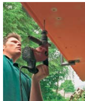
24. ... wurden unterseitig befestigt. Die Löcher hat man entsprechend der Pfostenmontageplatte gebohrt.
