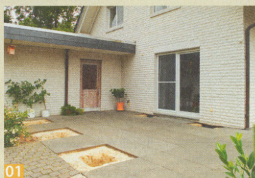
01 In diesem Beispiel werden fünf Pfosten benötigt. An den ermittelten Stellen werden die Löcher für die Punktfundamente ausgekoffert.
