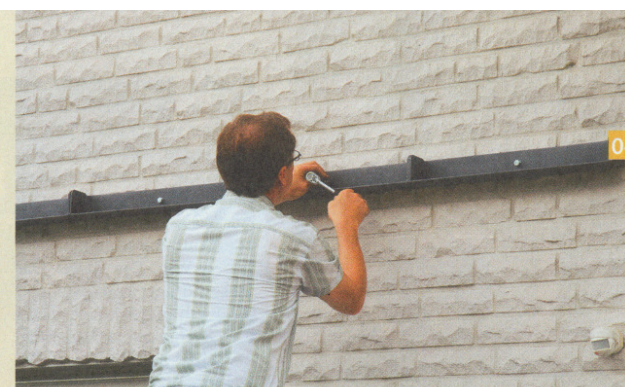
03 Das Dach bekommt ein Gefälle vom Haus weg. Entsprechend hoch werden die Dübellöcher für die Stahlpfette angefertigt.
