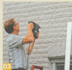
03 Das Dach bekommt ein Gefälle vom Haus weg. Entsprechend hoch werden die Dübellöcher für die Stahlpfette angefertigt.
