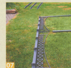
07 Die einzelnen Elemente für die Traufseite – die Pfette, die drei Stahlpfosten und Verbindungsornamente werden lose ausgelegt ...
