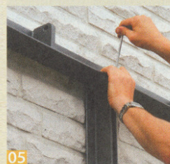
05 Unterstützend sind an der Hauswand zwei senkrechte Pfosten vorgesehen. Sie werden mit der Pfette verschraubt.
