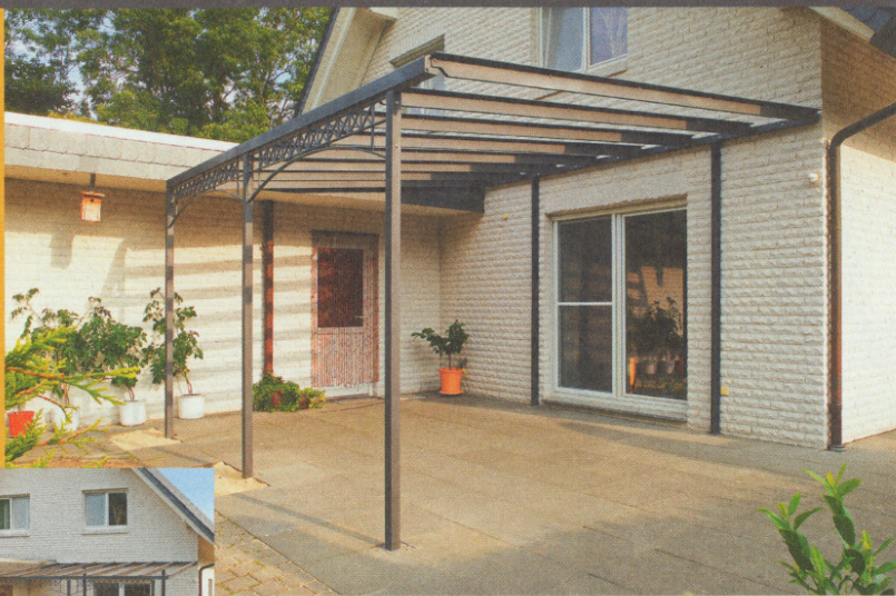
03 Das Dach bekommt ein Gefälle vom Haus weg. Entsprechend hoch werden die Dübellöcher für die Stahlpfette angefertigt.
