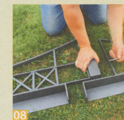
08 ... und dann mit den Spezial-Edelstahlschrauben miteinander verbunden: Erst die Pfettenteile mit den stabilisierenden ...
