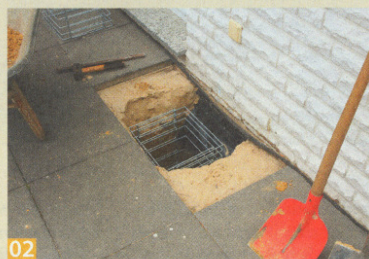
02 Als Bewehrung werden Drahtkäfige in die Löcher eingestellt. Vorsicht an der Hauswand: Die senkrechte Abdichtung darf nicht verletzt werden.
