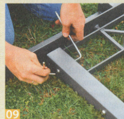
09 ... Ornamenten und dem mittleren Pfosten, dann werden die beiden anderen Stahlpfosten links und rechts angeschraubt.
