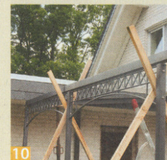
10 Das Ganze wird nun in die Fundamentlöcher eingestellt, senkrecht und in der Höhe ausgerichtet und mit Hilfsflatten ...
