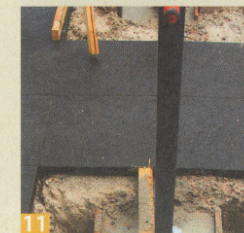
11 ... und Schraubzwingen fixiert. Anschließend können die bewehrten Fundamentlöcher mit Beton gefüllt werden.
