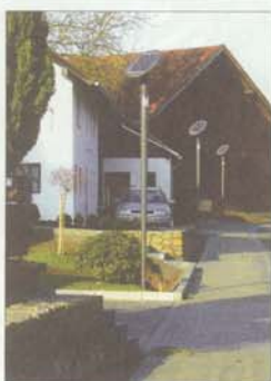
Solarleuchten StreetSun von EPS soltec. Werkfoto
